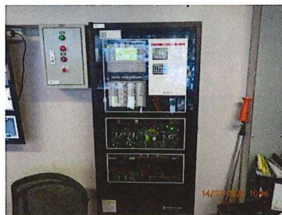
แผงควบคุม (Fire Alarm Control Panel : FCP)
