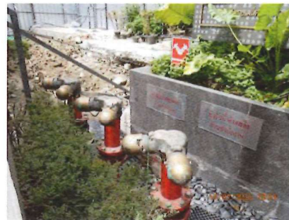
รูปที่ 1.8-3 หัวรับน้ำดับเพลิงภายนอกอาคาร
