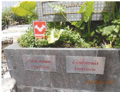
รูปที่ 1.8-3 หัวรับน้ำดับเพลิงภายนอกอาคาร
